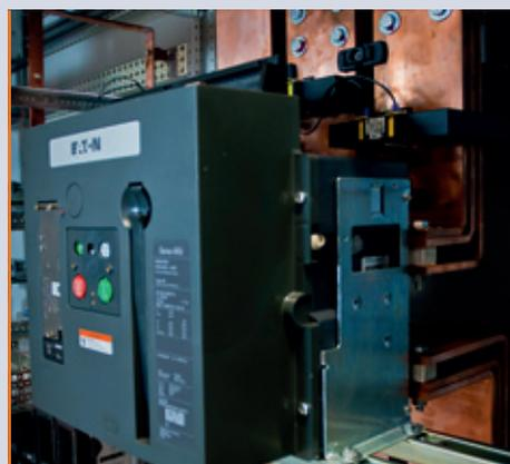
*Eigenproduzierte 4.000 A Schaltanlage zur Spannungsversorgung der Leistungsmaschinen*
